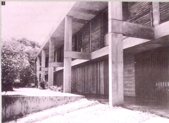
1 NA RESIDÊNCIA DOS PADRES DO COLÉGIO LOYOLA, A ESTRUTURA FAZ PARTE DA COMPOSIÇÃO ARQUITETÔNICA. CLARA EM SUAS INTENÇÕES FORMAIS E QUE, ASSOCIADA À SOLUÇÃO DE VEDAÇÃO RECUADA, EM VOLUME QUE SE SOLTA DA MARCAÇÃO ESTRUTURAL, VALORIZA A EXPRESSIVIDADE DO EDIFÍCIO
