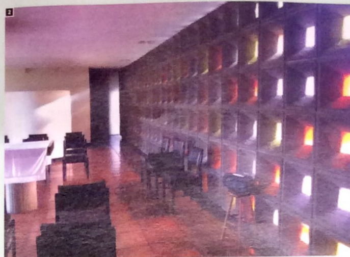
2 NA CIRCULAÇÃO DE SERVIÇOS DA RESIDÊNCIA DOS PADRES DO COLÉGIO LOYOLA, A ENTRADA DA LUZ NATURAL É CONTROLADA E FILTRADA PELO FECHAMENTO VAZADO DE BLOCOS DE CONCRETO, DEMARCANDO LIMITES MAS SEM IMPEDIR A CONEXÃO VISUAL COM O PÁTIO INTERNO
