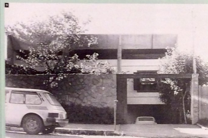
NA RESIDÊNCIA ULINS MARRA, A ESTRUTURA DEFINE A VOLUMETRIA E PARTICIPA COMO ELEMENTO COMPOSITIVO, CRIANDO OS LIMITES DO OBJETO CONSTRUÍDO, O QUAL SE DÁ RECUADO E SOLTTO DA MALHA ESTRUTURAL
